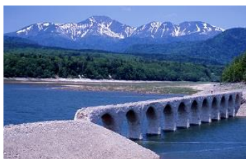
【タウシュベツ川橋梁】
